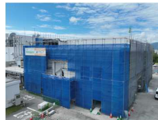
新工場建設中
